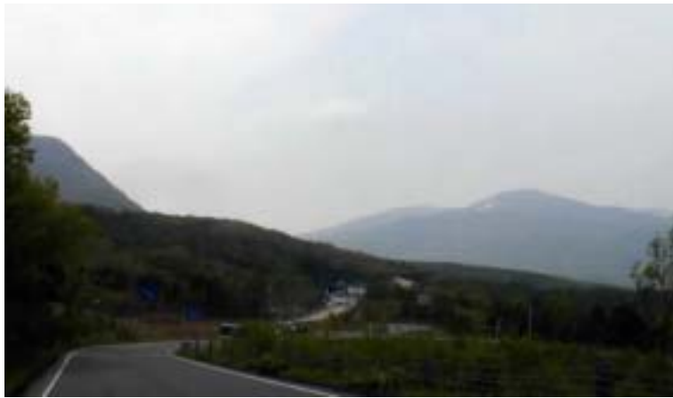
国道 115 土湯トンネル ゲート近傍 2003.5.25.
