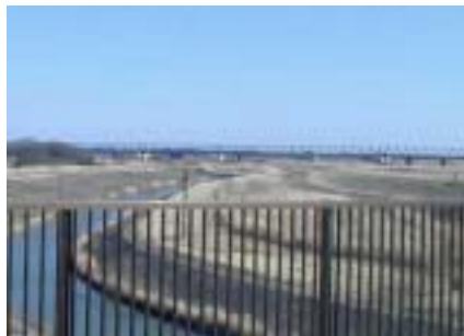
利根運河入口柏近傍 遠景は建設中の筑波エクスプレス
