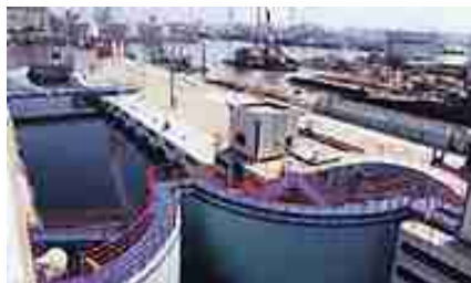
新第2閘門（平成6年度完成）
