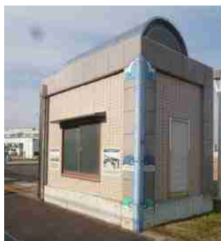
地盤沈下計測所
