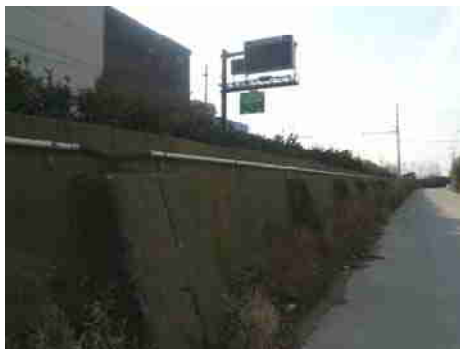
大高洲 旧防潮堤
