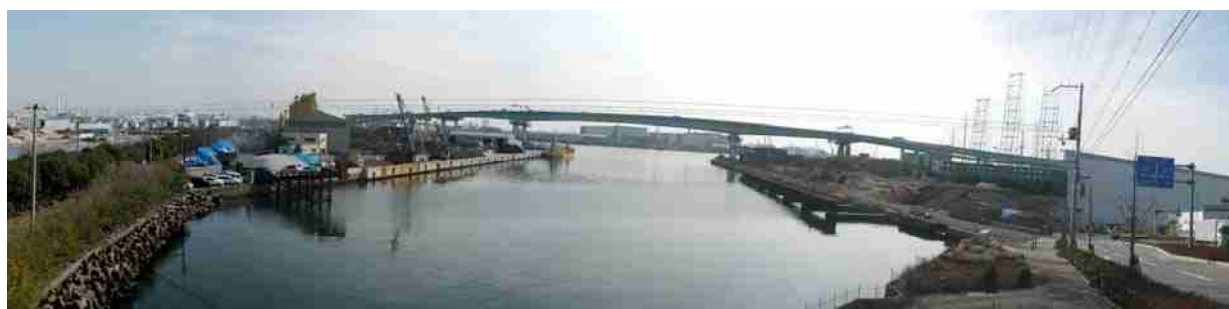
尼崎港閘門 尼崎ロック周辺 末広町運河 左手が尼崎ロックへの道
