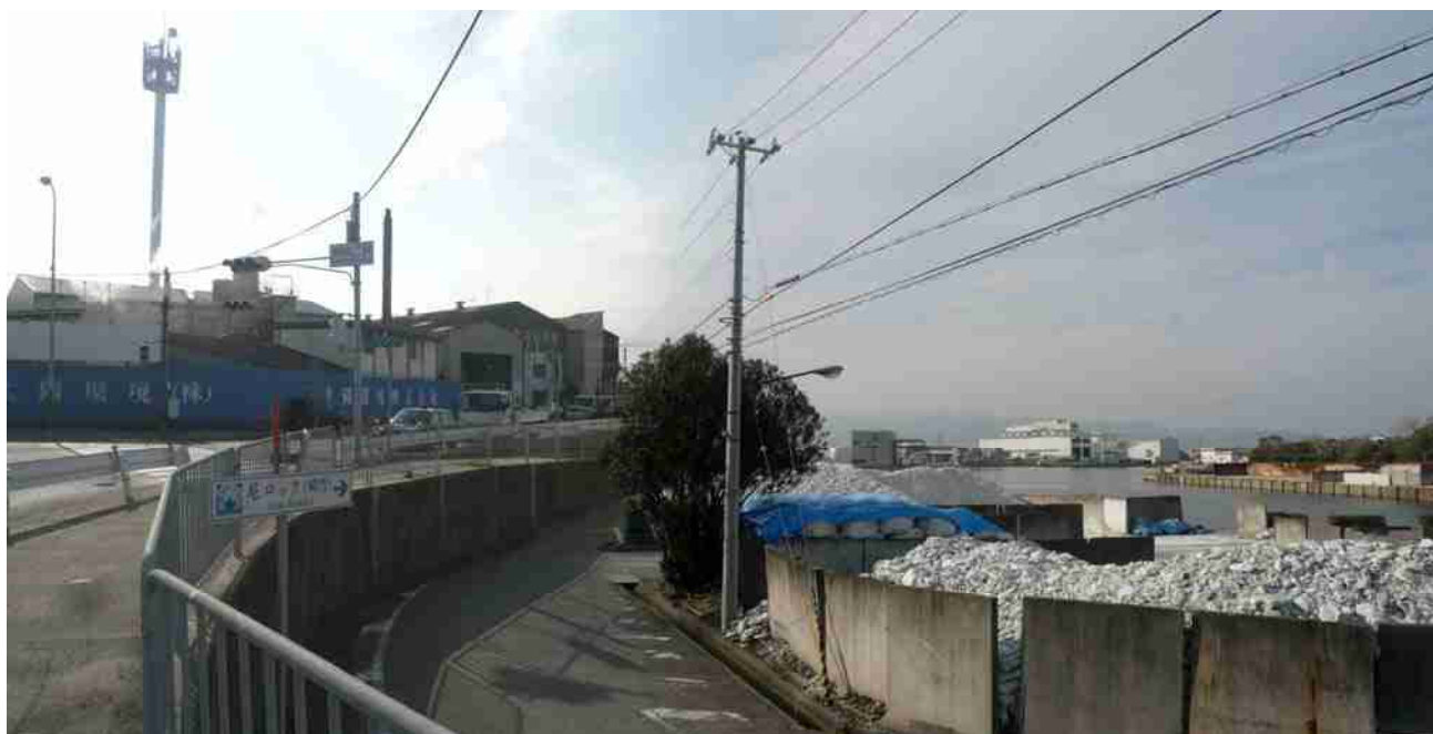
大高洲から 旧防潮堤に沿って 西へ 右手奥に尼崎港閘門・尼崎ロックがみえる
