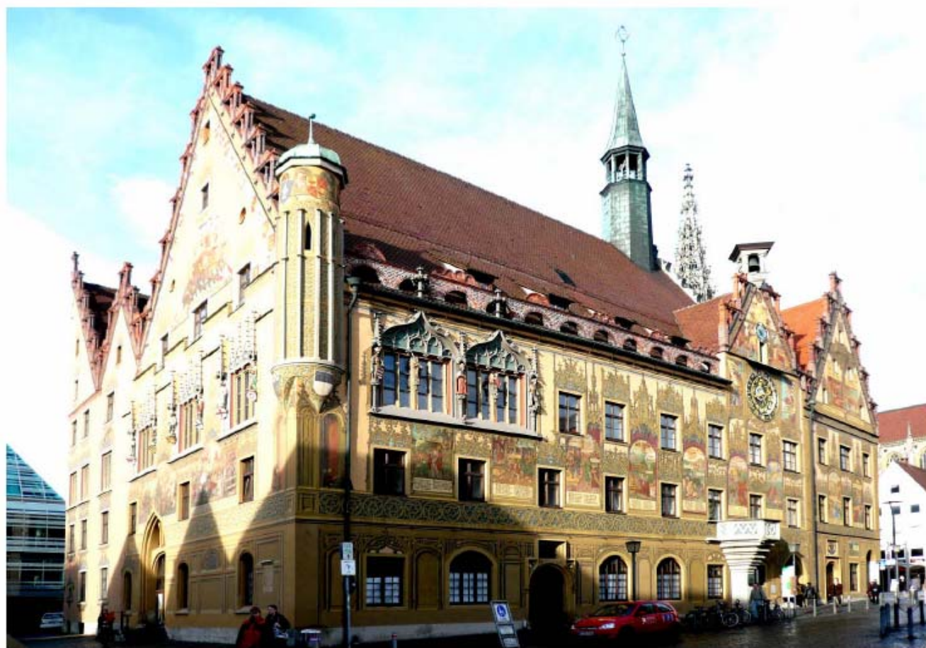
壁面全体にルネッサンス調の壁画がある旧ウルム市庁舎 2007.12.6.
