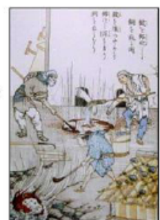
b. 酸化銅成分を溶融と酸化脱硫(高吹き) 図の中央に空気吹付け口が見える
