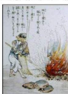
地炉加熱による硫化銅成分と 銅スラグとの分離
