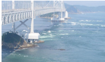
鳴門海峡・大鳴門大橋
