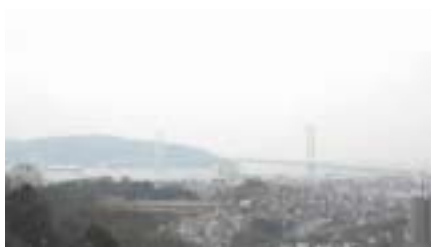
明石海峡と明石大橋
