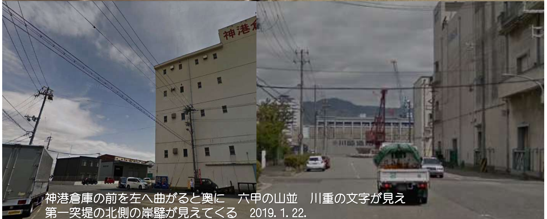
兵庫埠頭 第一突堤の北側の岸壁
