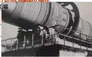
川崎製鉄久慈工場 ロータリーキルン(回転炉)
