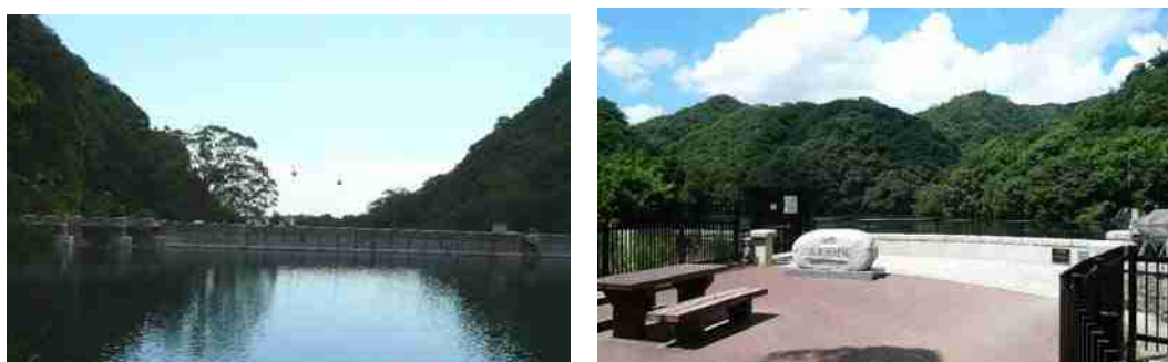
重要文化財 神戸ウオーターの源 布引貯水池 2010.8.26.
