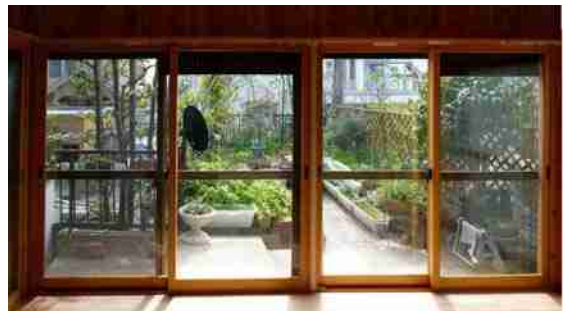
自宅のサンルームから漏れくる春の陽 雨漏りして物置になっていたサンルームを改造 気持ちのいい空間になりました
