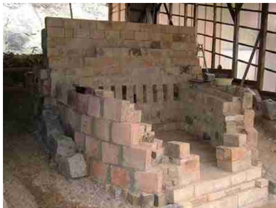
窯の煉瓦積みが進行中 登り窯の一番下 大口・一の間の煉瓦積み の真っ最中（田中講平さんより）
