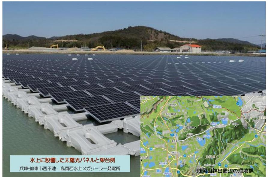
水面上に設置した太陽光パネルと架台例
