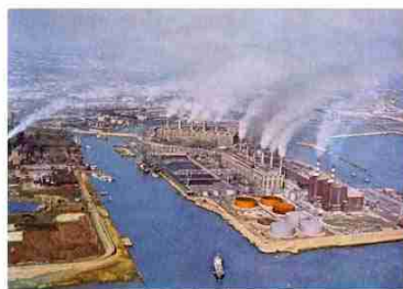
1964年 関西電力 第一・第二発電所
