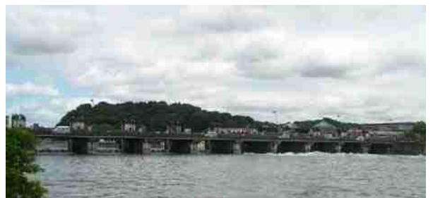
琵琶湖の水の調整弁 瀬田川 南郷の洗堰
