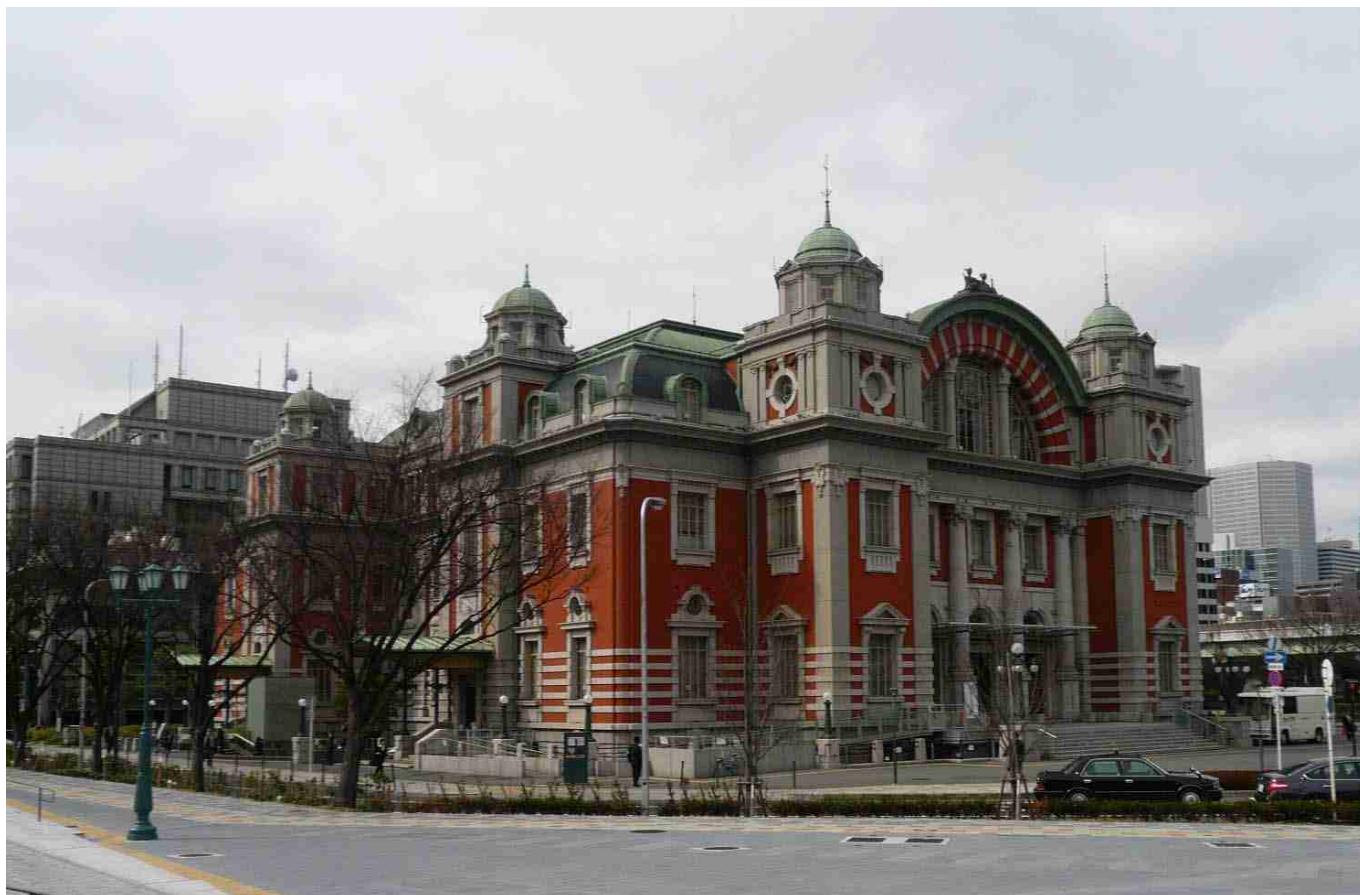
重要文化財 中央公会堂 2010. 3. 2.
