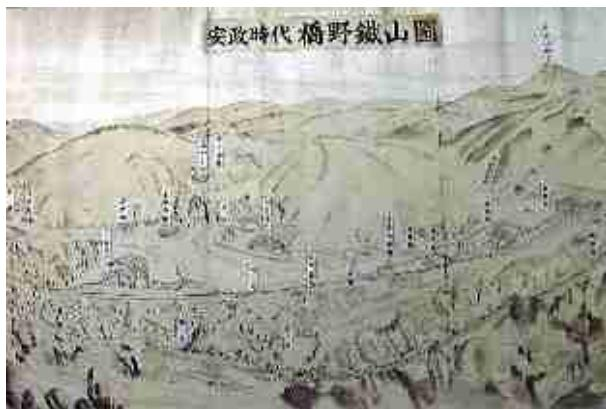
この豊富な鉄鉱石を原料に安政3年 高島高任によって、日本初の洋式高炉（大橋高炉）が建設。その後この山中 大橋に3座、橋野に3座、左比内に2座、栗橋及び砂ばん子渡に各1座合計10座が良質豊富な鉄鉱石の産地を背景にいずれも高任の指導によって建設された。これらの高炉は鉄鉱石を原料とし、銑鉄の製造に成功した我が国最初の洋式高炉である。
