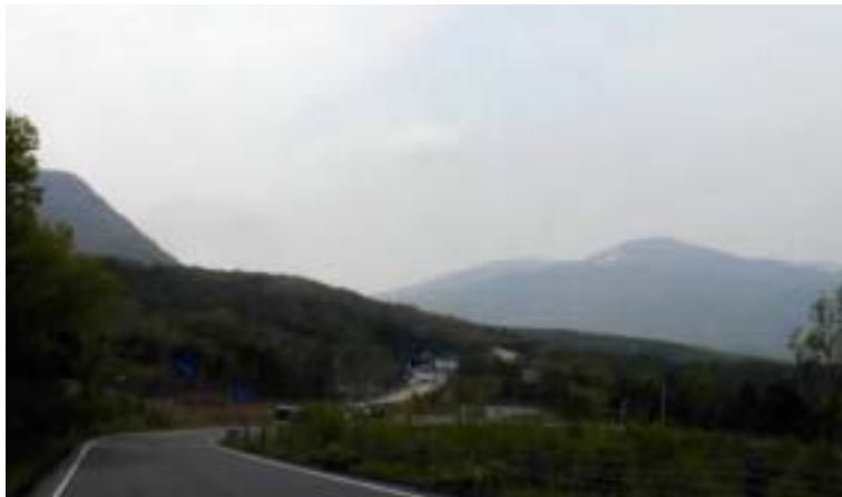
国道 115 土湯トンネル ゲート近傍 2003.5.25.
