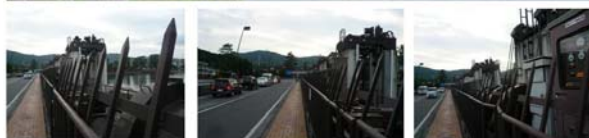
瀬田川 南郷洗堰(下流側)と洗堰の上を渡る黒津／南郷を結ぶ道路 2009.7.12.
