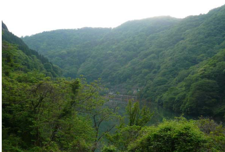
上流側から見た喜撰山揚水発電所水圧鉄管落ち口周辺
