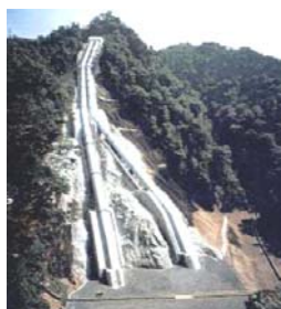
敷設されたペンストック(水圧鉄管)の例 インターネット検索より
