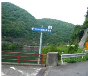
橋の上流側に水圧鉄管の落ち口が見える
