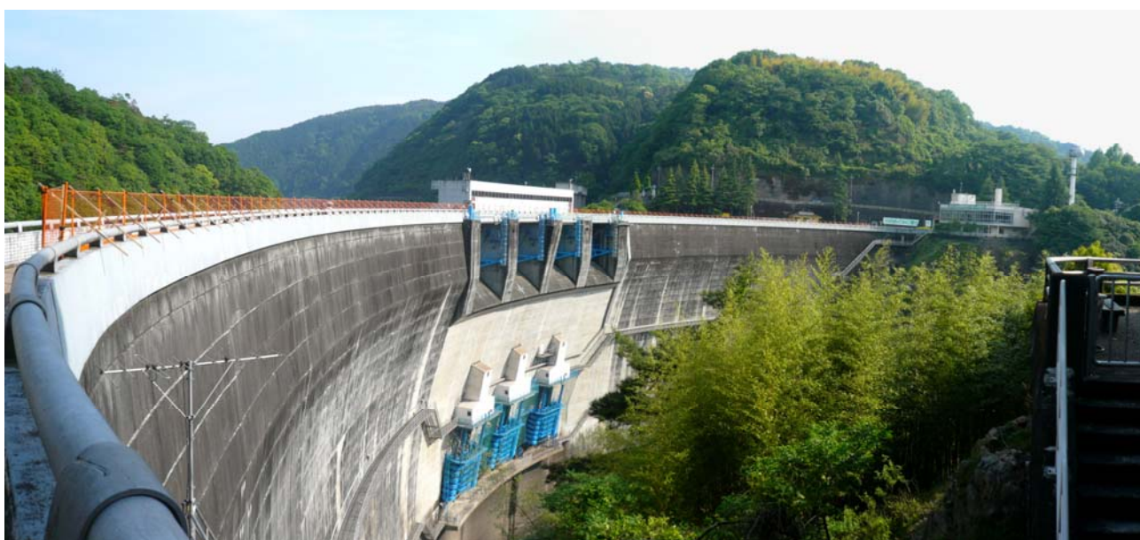
対岸に渡りきった所からの堰堤
