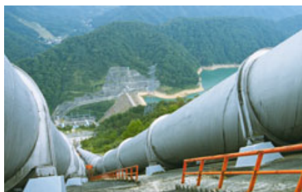
敷設されたペンストック(水圧鉄管)の例 インターネット検索より
