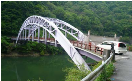
喜撰山発電所の入口 喜撰山大橋
