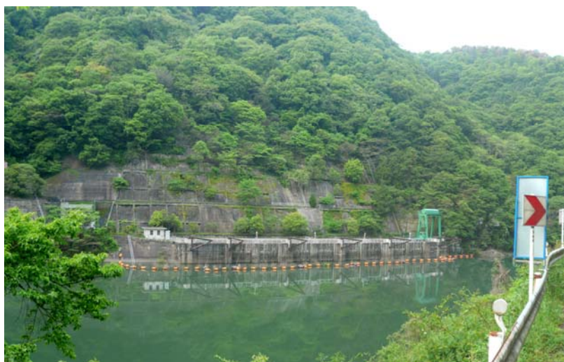
喜撰山発電所の下池落ち口（揚水発電所 取水・放水口）
