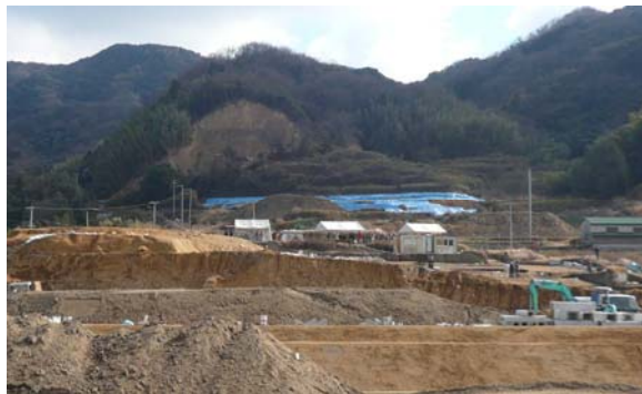
2007 年調査部 周辺 ④-1・2 地区
