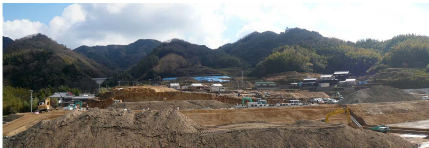
尾根筋の最下部より 尾根筋に広がる遺跡全体 2008. 1. 25. 2007 年調査部は既に埋め戻されている
