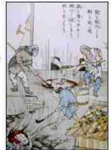
b. 硫化銅成分分離と酸化脱炭[表吹き] 国の中央に空気吹付け羽口が見える
