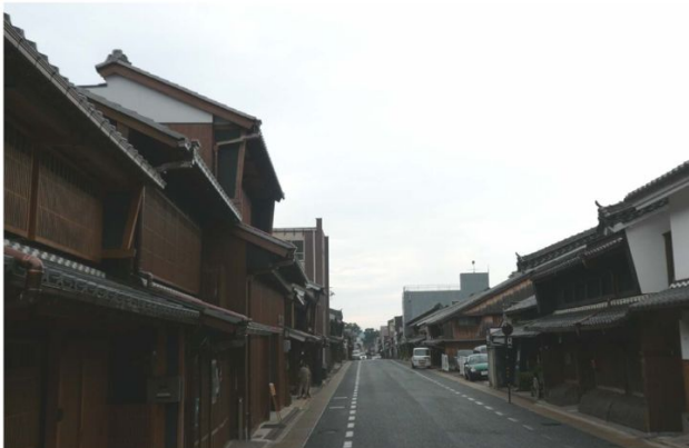
「うだつ」のあがる町並み「美濃」重要伝統的建築物群保存地区 2007.9.10.
