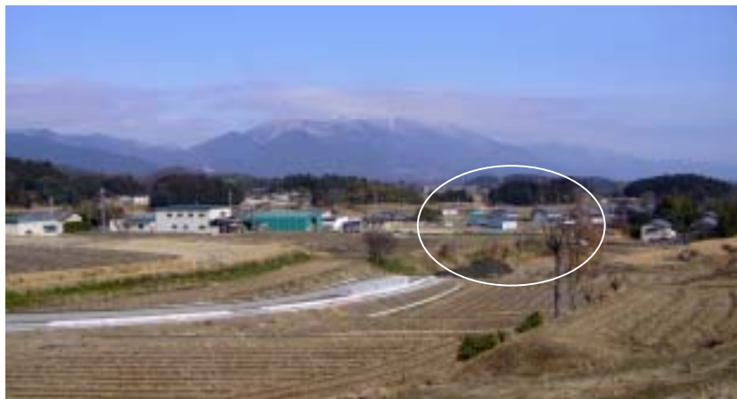
途中越の伊香立へとつなぐ工事中のバイパス道路と上仰木遺跡
