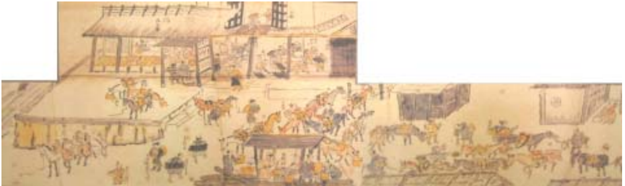
下巻部分 鉄山の事務所 勘場
