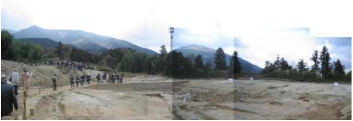
南東端より 全体を見る 背後に金剛山 葛城山が見える 2005.2.26.
