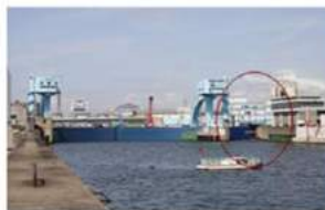
副水門完全閉鎖
