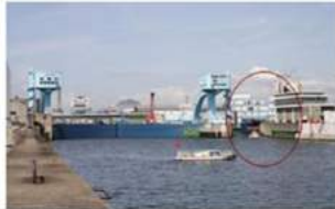
副水門閉鎖作業中
