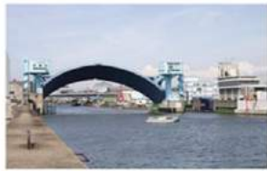
主水門閉鎖作業中
