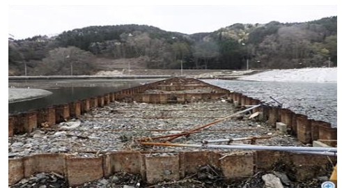
襲われた巨大津波からも守れた鋼板杭列の壁
