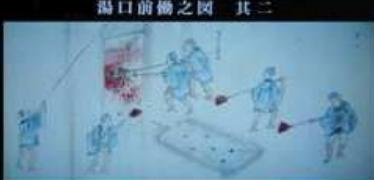
鉄鉱を出し切った後、出鉄口の穴を塞いでいる。
