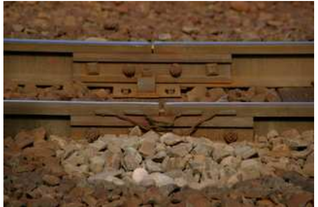
旧レールの継ぎ目
