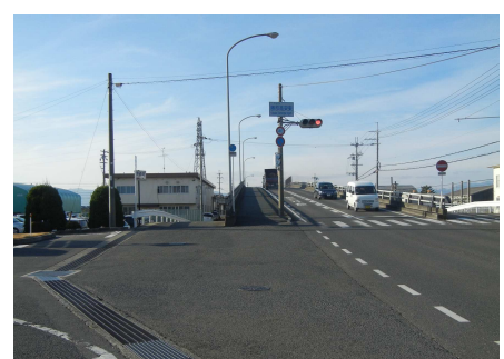
伊勢町の JR 跨線橋
