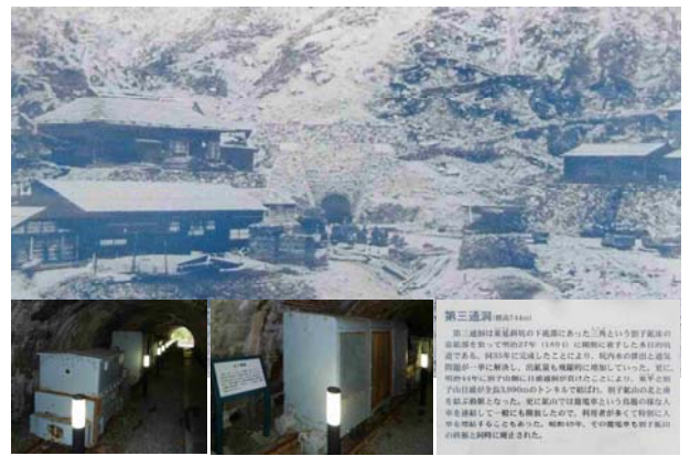
第三通洞 明治35年完成 明治44年別子山側に日浦通洞がぬけ、東平と日浦がトンネルで結ばれ、別子鉱山の大動脈となった。 また、かご電車と呼ばれる鳥かご電車を連結して一般にも開放。 昭和48年閉山廃止まで多くの人も運び続けた。
