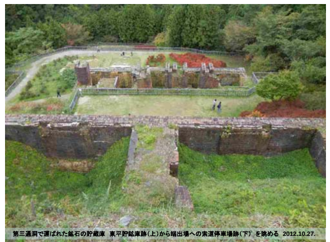
東平貯鉱庫跡 明治35年(1902)に第三通洞が貫通し、明治38年(1905)に東平の中央に新選鉱場が、東平一帯に新選鉱場が、新選鉱場から第三通洞を経て東平貯鉱庫に運搬する電気鉄道がそれぞれ完成した。大正5年(1916)には、東平本所が東平(第三通洞)に移転して、東平が新選鉱場となる。 第三通洞から搬出された鉱石は、大マンブ、橋井橋、小マンブを渡って終点の新選鉱場に運ばれた。鉱石と岩石と共に搬出された鉱石は貯蔵庫に貯められ、順次索道で東平貯へ下ろされた。後には新選鉱場を短期して東平貯から端出場へと変更して下ろされ、新選鉱場に運ばれた。
