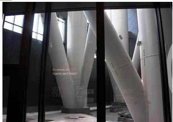
図4●塔体最下部に使用された鋼管 建築現場に納入する際には、分岐する鋼管をあらかじめ溶接・塗装した状態で運び込む。(写真:大林組)
