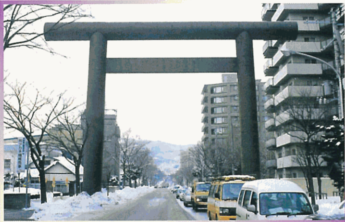
北海道大神宮(大鳥居) 昭和43年/北海道札幌市 高さ 19.1m/幅 25.4m/柱径 1.9m/柱間隔 14.8m
