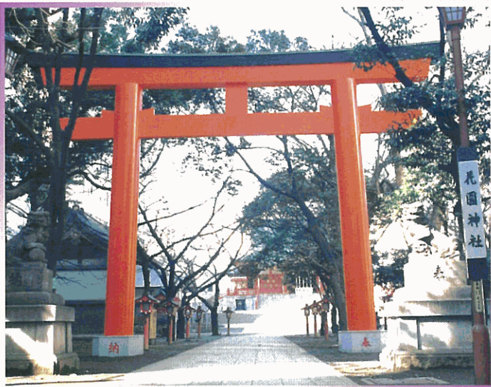
花園神社(鳥居) 平成8年/東京都新宿区 高さ 9.28m/幅 12.9m/柱径 0.81m/柱間隔 7.0m
