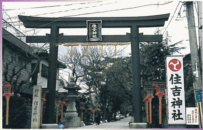
住吉神社(鳥居) 平成8年/大阪府豊中市 高さ 5.76m/幅 8.01m/柱径 0.45m/柱間隔 4.5m
