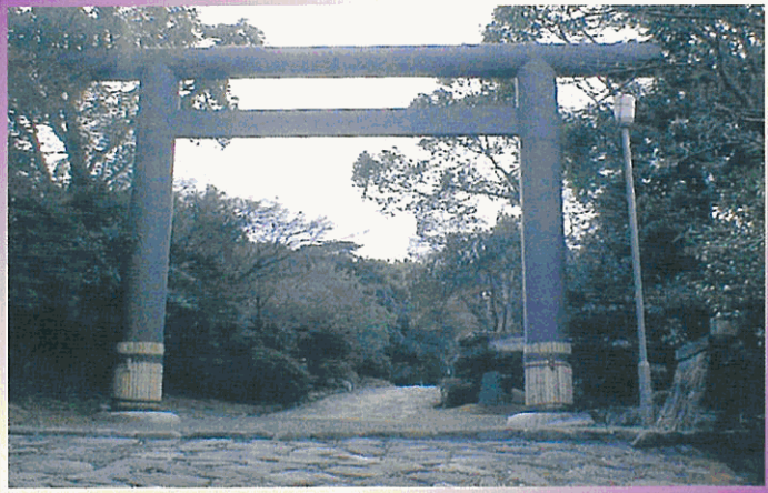
伊曾乃神社(鳥居) 平成元年/愛媛県西条市 高さ 9.5m/幅 13.2m/柱径 0.87m/柱間隔 7.9m
