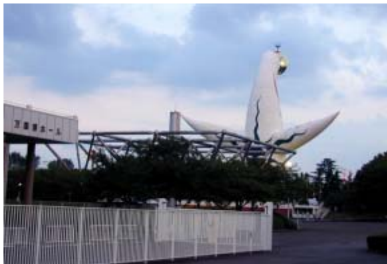
自然園の北側から「お祭り広場 大屋根のモニュメント」
