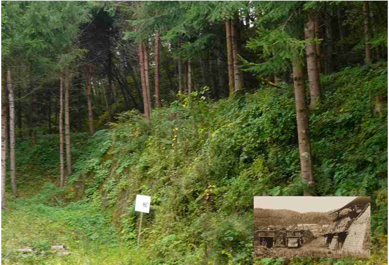
諏訪鉄山の鉱石の集散ホッパー施設 金堀場万石跡 ここからトラック輸送で運び出された 2010. 10. 17.
