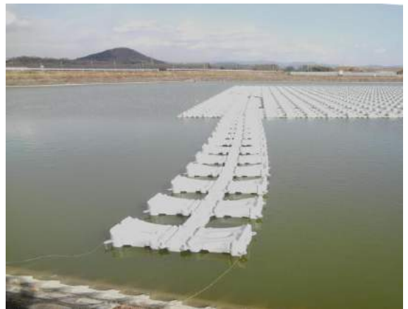
神出の里の溜池 合ノ池に浮かぶ白い筏の正体はやっぱり 太陽電池パネル設置用の架台でした 2016.2.25
