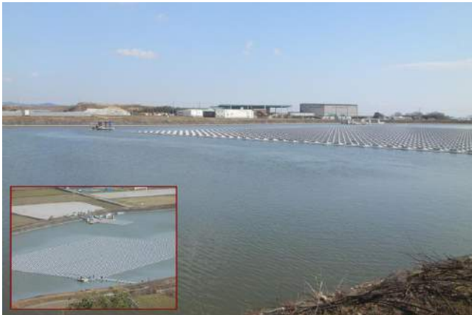
神出の里の溜池 合ノ池に浮かぶ白い筏の正体はやっぱり 太陽電池パネル設置用の架台でした 2016.2.25
