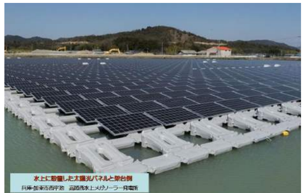
神出の里の溜池 合ノ池に浮かぶ白い筏の正体はやっぱり 太陽電池パネル設置用の架台でした 2016.2.25
