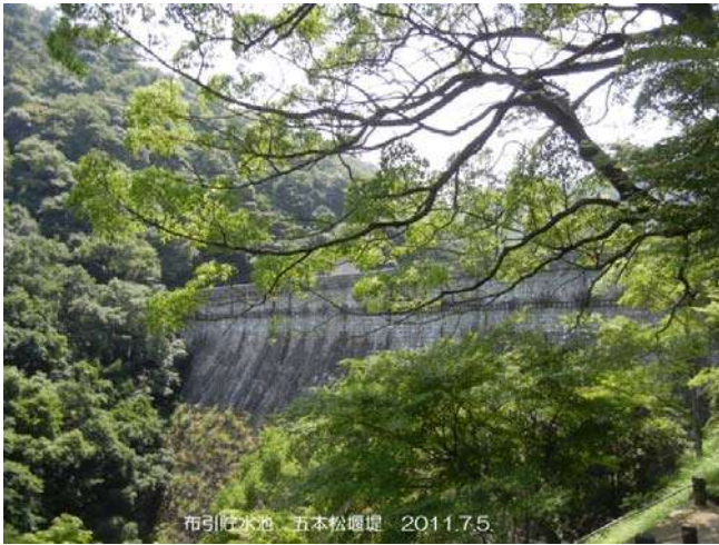
布引谷の上 布引貯水池 六本松堰堤
