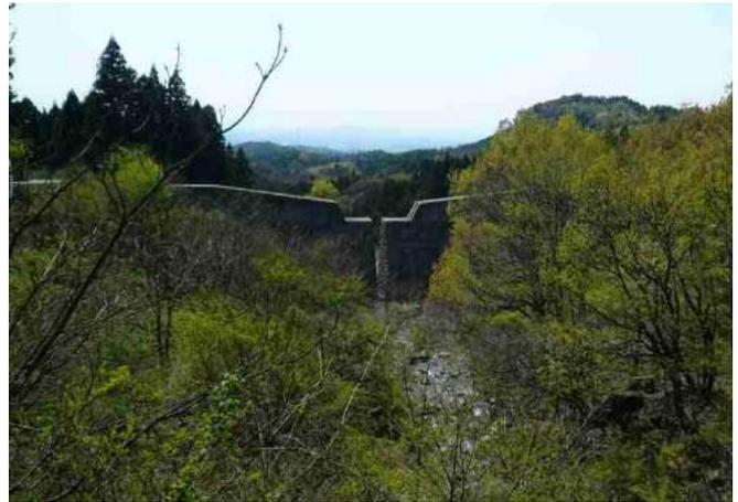
接触変質地帯をまっすぐに流れ下る西明寺川に設けられたスリットの深い砂防ダム堰堤 2010. 5. 2.
