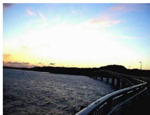
西長門 新設された角島大橋
