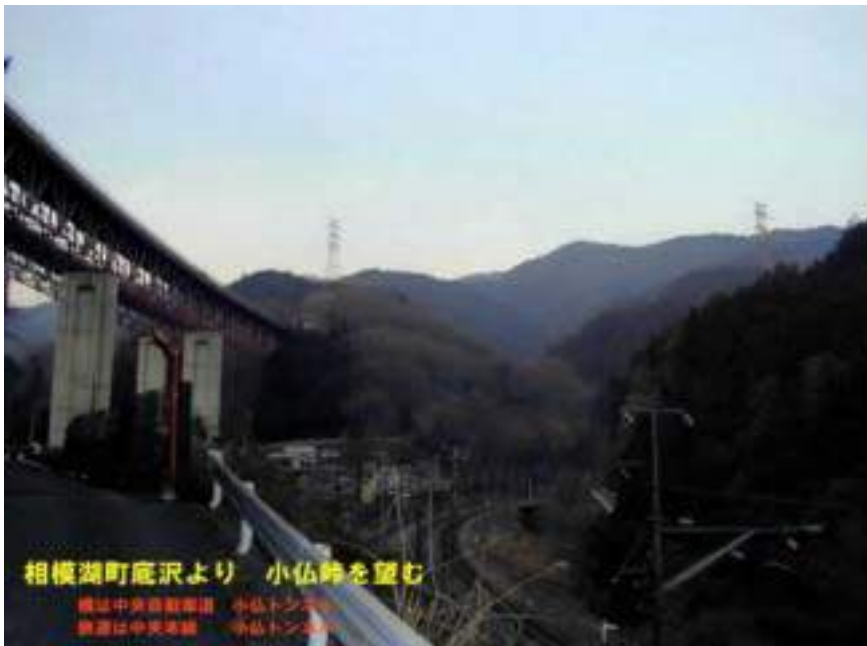
底沢から小仏峠を望む 中央自動車道・中央線トンネル
