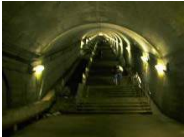
下り駅 新清水トンネル内 日本一の地下モグラ駅
