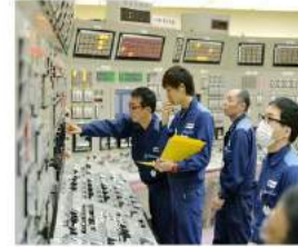
朝日新聞 DIGITAL 高浜原発4号機が緊急停止 再稼働直後、変圧器で異常か
