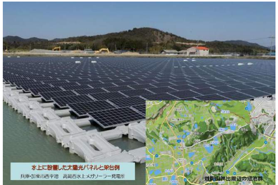
インターネットで調べた溜池に架台をつないで並べた白い浮き筏に設置された太陽電池パネル例 そっくりで 日照り続きの日照時間が長い播磨平野の溜池群は格好の太陽電池パネル設置場所。 これから 次々と溜池にパネルが設置されるのだろう
