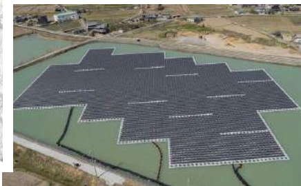
インターネットで調べた溜池に架台をつないで並べた白い浮き筏に設置された太陽電池パネル例 そっくりで 日照り続きの日照時間が長い播磨平野の溜池群は格好の太陽電池パネル設置場所。 これから 次々と溜池にパネルが設置されるのだろう
