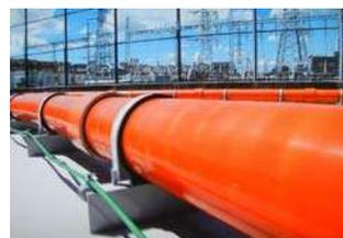
高温超伝導体ケーブルでの送電実証化テスト
