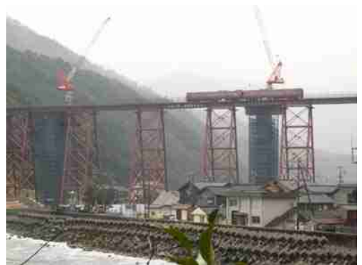
2010 年 新コンクリート橋への架け替え工事が進む
