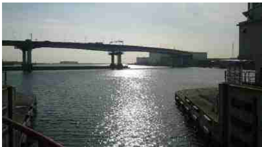
大阪湾 尼崎港・尼ロックより
