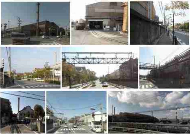
尼崎南部の工場地帯 東向島・東高洲
