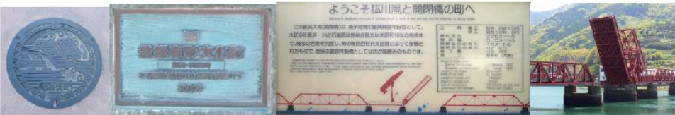
鉄のモニュメント 愛媛県 大洲市長浜 鉄10の河口に架かる日本最古の現役道路開閉橋
