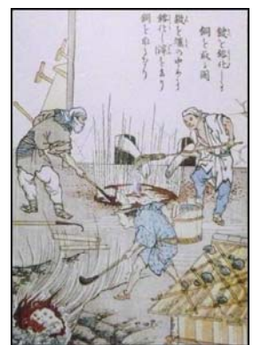
カワを再度溶融 硫黄を飛ばして荒銅を作る
