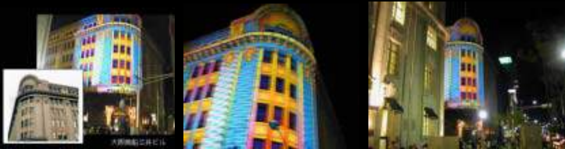
大阪商船三井ビル
