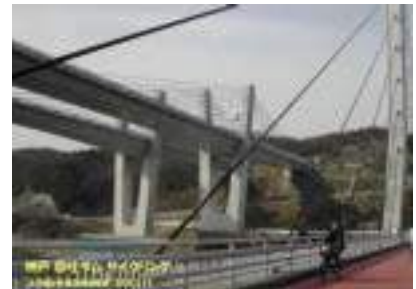
神戸市北区呑吐ダム サイクリングロードで
