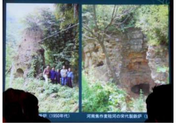
◎ 炉壁には石が用いられ、石の継ぎ目には耐火粘土が塗られ、炉内や周辺から大量の鉄滓、鉄鉱石、木炭が見つかった。
