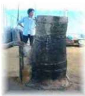
古代朝鮮半島の製鉄炉復元
