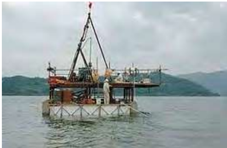
福井県・水月湖の掘削の様子
