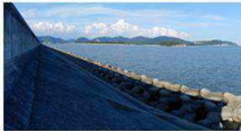
東側の防潮堤
