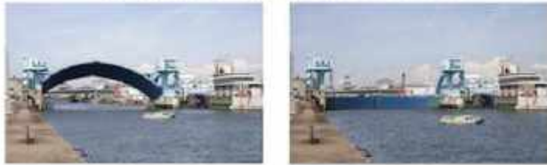
主水門閉鎖作業中 → 主水門完全閉鎖
