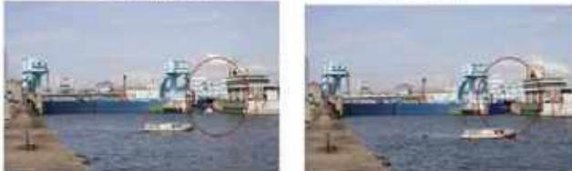
副水門閉鎖作業中 → 副水門完全閉鎖
