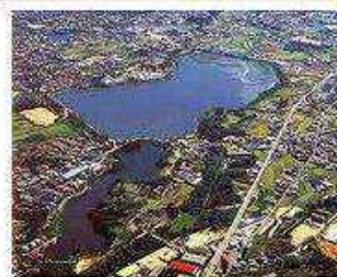
平成の大改修前の狭山池
