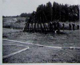
焼失した復元整備建物(三内丸山遺跡)
