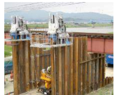
騒音無振動圧入法
