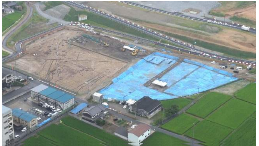
今回発表された中西遺跡 第26次調査地で 26棟の竪穴住居などが出土 古墳時代前期 祭祀を目的とした大集落「秋津・中西遺跡」の居住区の一部
