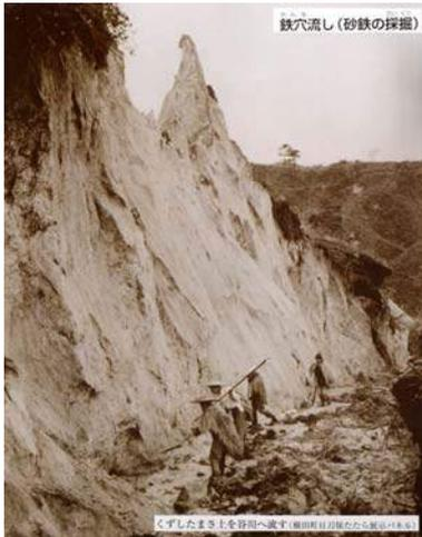
鉄穴・切羽 砂鉄採取
