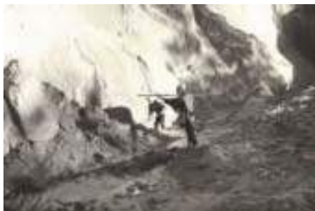
山砂切り崩し
