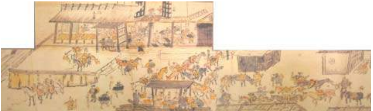
下巻部分 鉄山の事務所 勘場
