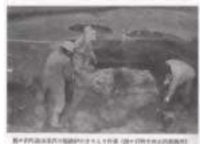
傾斜地の斜面に長さ 1m 前後 幅 50cm 弱 高さ 30cm 程度の製鉄炉が数基づつ整然と並び、その前にこれらの前庭部には共用される廃滓ピットと作業場がある。
