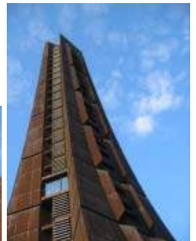
街であまり見なくないが メンテナンスのしにくい山間部の橋梁などに使われその耐食機能を発揮している。でも この耐候性鋼 サビが付着安定するまでに時間が必要でそれまでは サビが流れ出し、まわりを汚すので無塗装での使い道がその後伸びず苦勞した材料。
