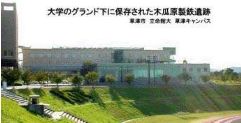
木瓜原製鉄遺跡が地下に保存された草津キャンパス グラウンド 立命館大 草津市
